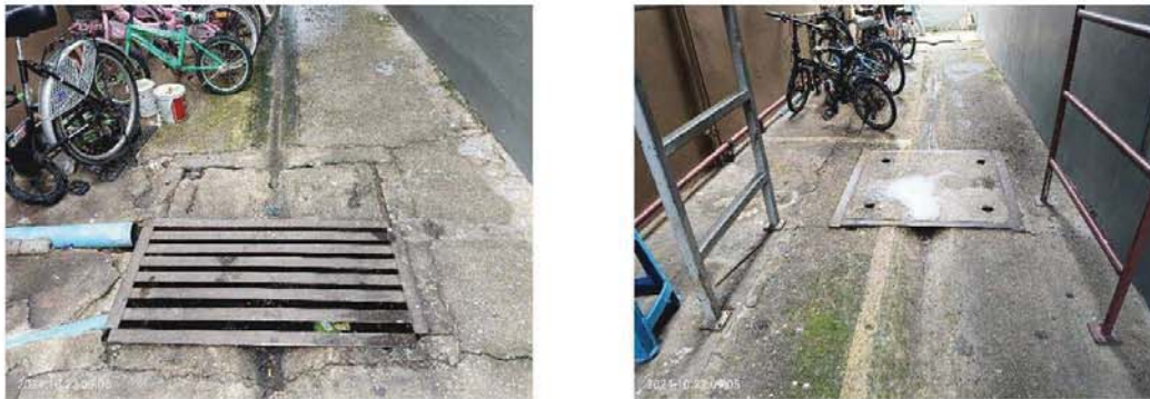
ท่อระบายน้ำ หรือบ่อพักน้ำรอบโครงการ
