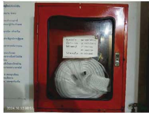
ตู้เก็บสายฉีดน้ำดับเพลิงพร้อมอุปกรณ์
