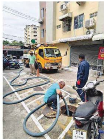
พื้นที่ระบบบำบัดน้ำเสียแบบบ่อเกราะ-กรองไร้อากาศ
